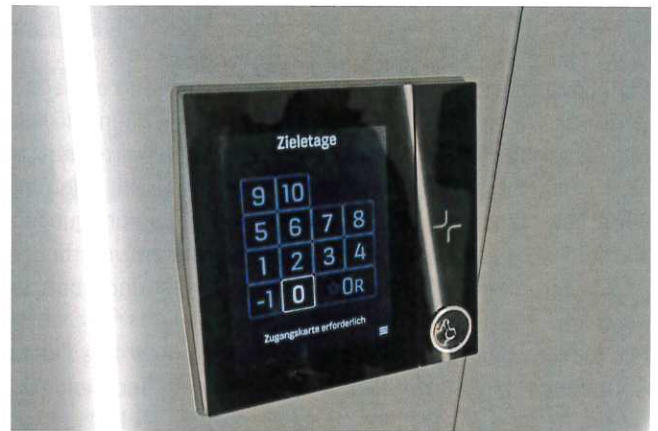
Aufzug mit automatischer Logistik spart Energie.
