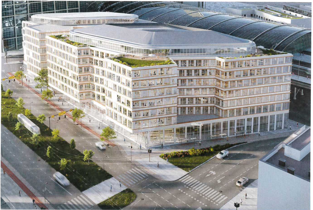
Edge Grand Central am Berliner Hauptbahnhof – Bürogebäude 2.0
