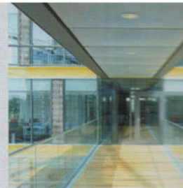
Eine der Verbindungsbrücken im Atrium mit unterseitigen Deckenstrahlerelementen.
