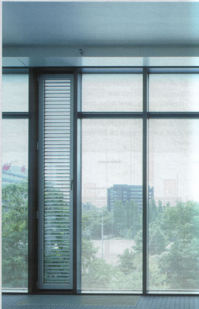
Fassadenanschluss mit Weitwurf-Sprinklerung
