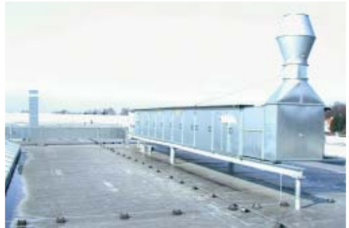
Bild 3: Dachansicht der Abluftreinigungsanlage
