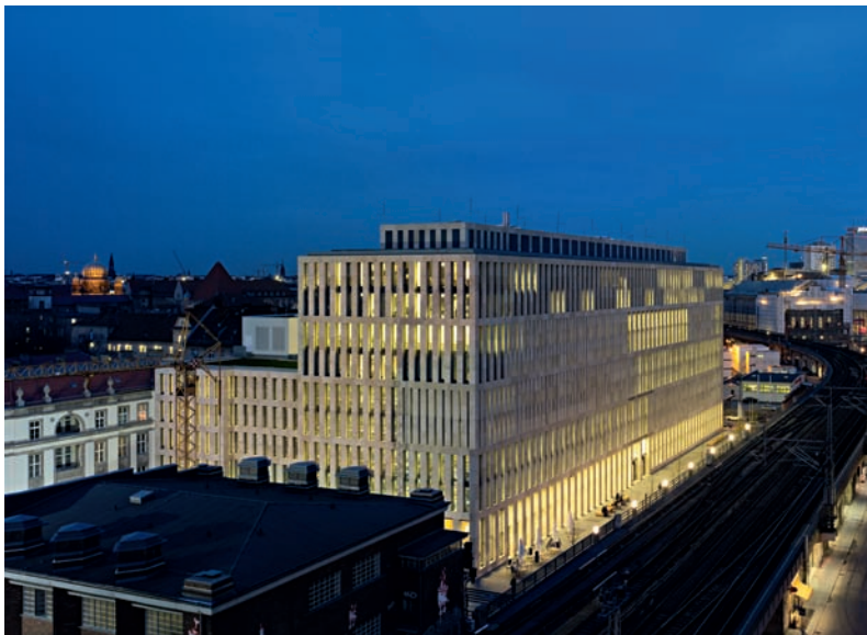
Der kompakte Baukörper minimiert Energieverluste. | The compact building minimises energy losses.
