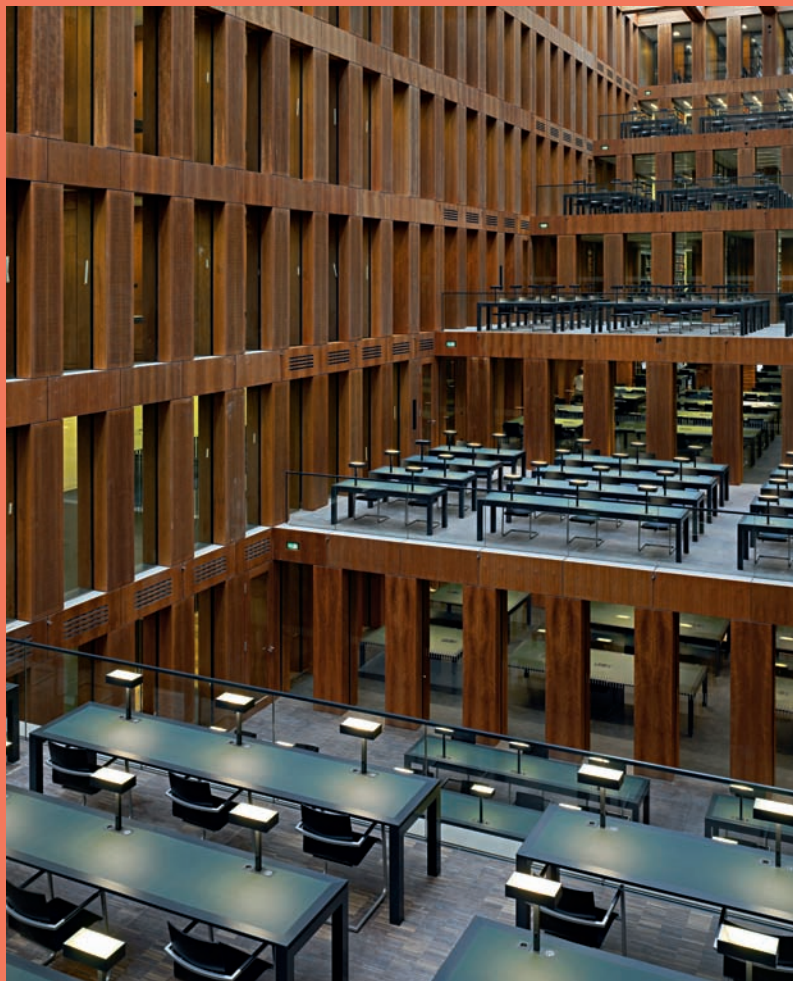
Innenfassade des Lesesaals mit integrierten Luftauslässen | Internal facade with integrated ventilation slots
