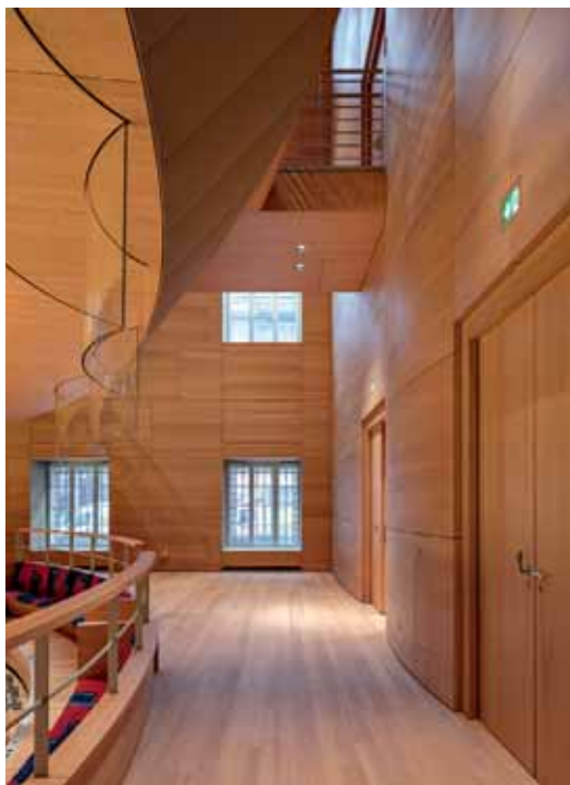
Der Rang ist mit Stoff bespannt, die Hohlkammern dahinter sind Teil des akustischen Konzepts. Kleines Foto: Till Schuster, großes Foto: Roland Halbe
