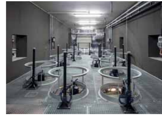
Der rote Stahlträger spannt 25 Meter über den Konzertsaal. Im Inneren ist das Technikgeschoss untergebracht. Im Bild die steuerbaren Leuchten des „Sternenhimmels“
