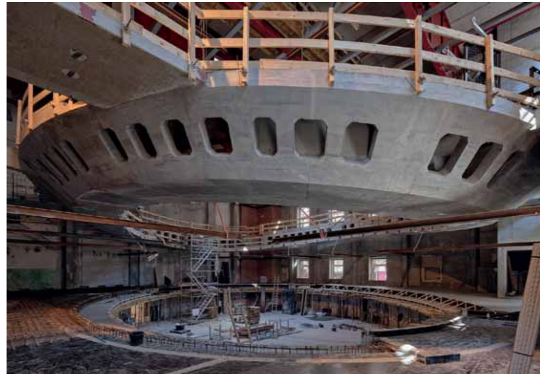
Drei Bauetappen des Saals, von links: Aussteifungskern mit Abstützung der Außenwände, Schalung des Rangs, Rang im Rohbau Fotos: Till Schuster
